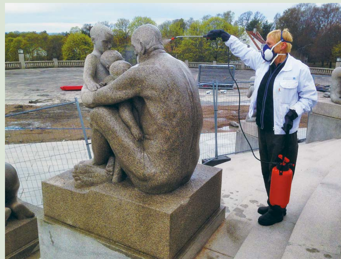
Biologisk vekst er en utfordring for granittskulpturene i Vigelandsparken. Etter den årlige vårrengjøringen dusjes granittgruppene på sirkeltrappen med en blanding av etanol og vann for å hindre at alger, mose og lav vokser på dem.
