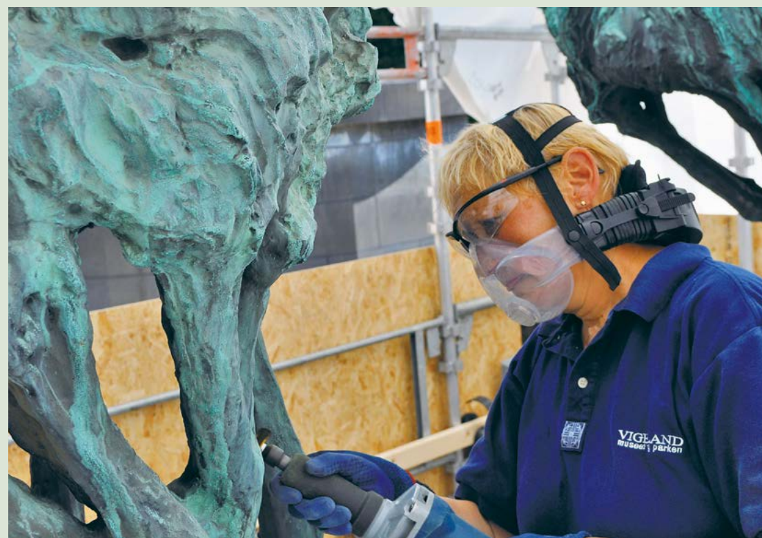
Konservator Ingebjørg Mogstad i arbeid med å fjerne svarte skorper med avleiringer og korrosjon. Konservatorene jobber på denne måten for å gjenskape skulpturenes opprinnelige uttrykk.
